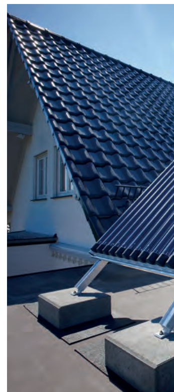
panneaux solaires thermiques à
